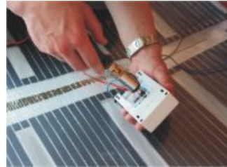
7. Podłączenie termostatu.
