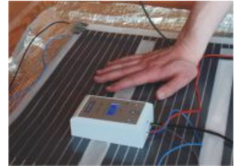
8. Test działania połączeń.
