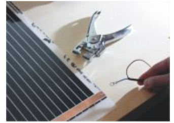
4. Wycięcie otworów instalacyjnych przy pomocy nitownicy.
