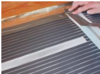
9. Przymocowanie maty do podłoża.
