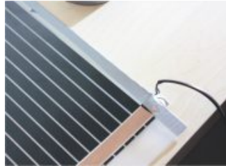
6. Izolacja połączeń zasilających.
