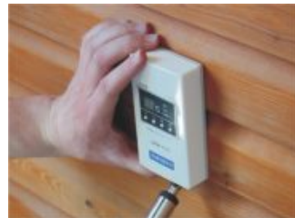
11. Instalacja termostatu.
