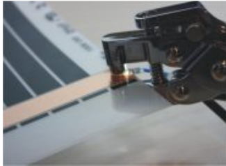
5. Podłączenie przewodów zasilających.
