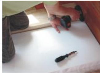
2. Instalacja izolacji.
