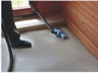
1. Oczyszczenie powierzchni podłogi.
